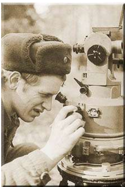
НРНР устанавливает теодолит
